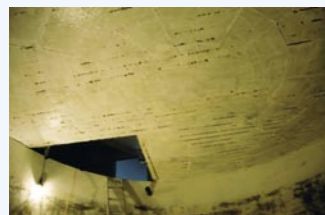
Bewehrungskorrosion
